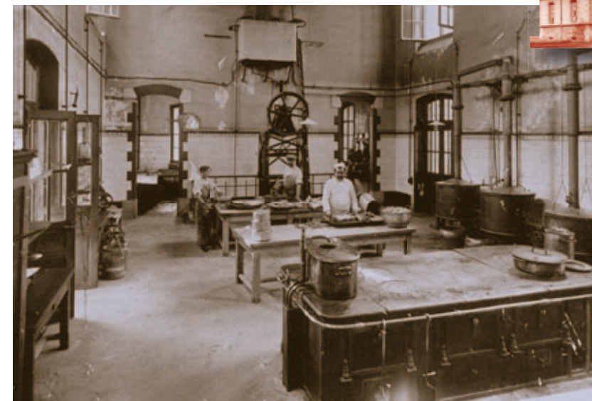
Cuisines de l'asile des vieillards , un équipement modèle à l'époque. En 1893, un marché forfait est contracté avec M. J. Grouvelle et H. Arquembourg pour l'installation des appareils devant fournir la vapeur nécessaire au chauffage des divers pavillons ainsi que celle utilisée à la cuisine, à la buanderie, aux bains et à l'élévation des eaux vannes provenant du tout-à-l'égout. Coll. MGSM.
