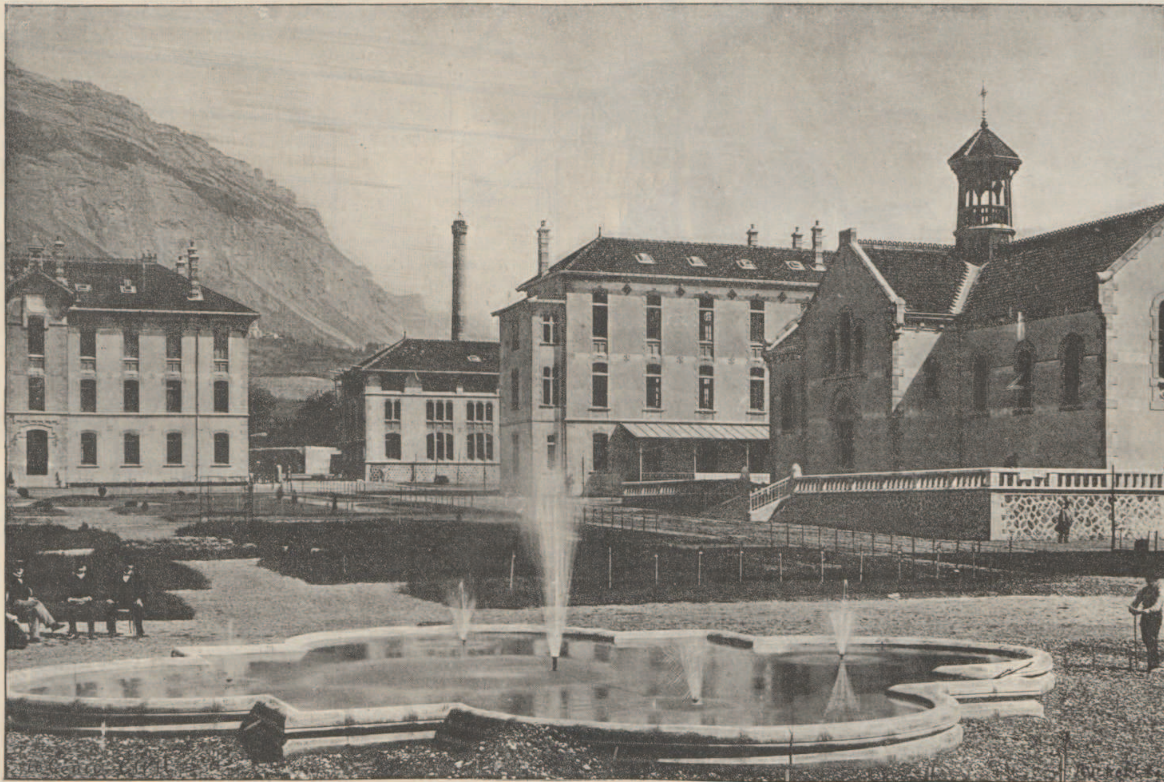
FIG. 3. — Vue intérieure de l'Asile de vieillards de la Tronche, à Grenoble.
