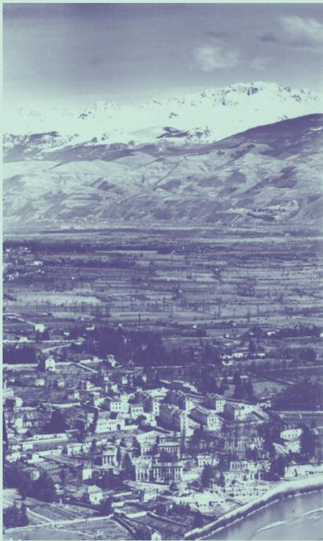
Vue aérienne de l'hôpital de La Tronche : construction (1910-1914)
